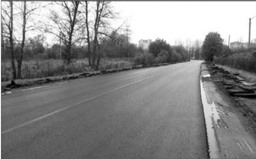
Отремонтированный проезд Энергетиков в Промзоне №1
