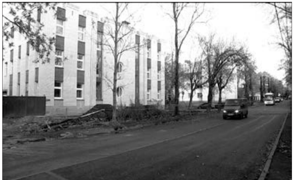
Отсутствующий тротуар у здания новой прокуратуры: жители недовольны
